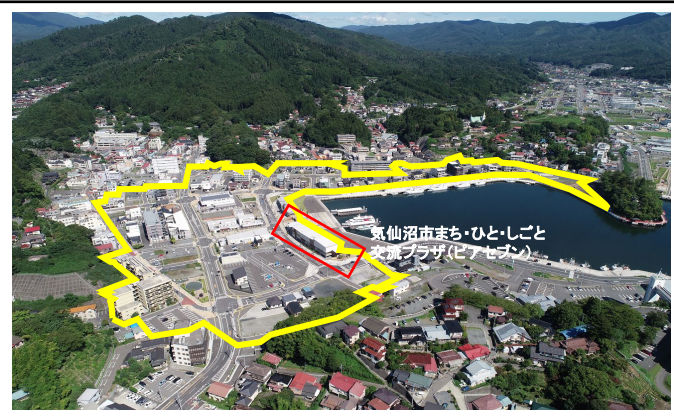
土地区画整理事業が完了した魚町・南町地区
